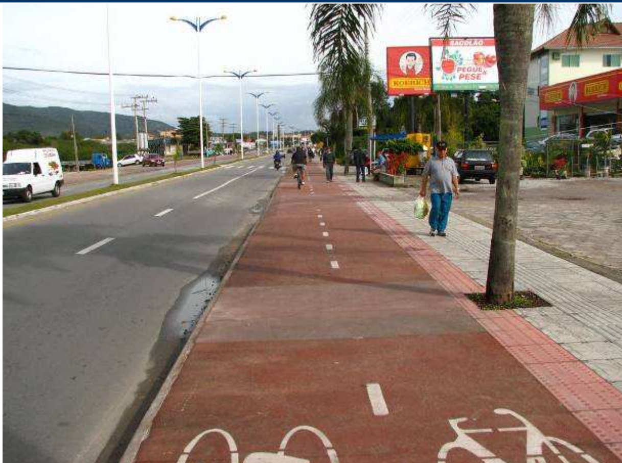
Ciclovia na Sc - 403 - Ingleses
