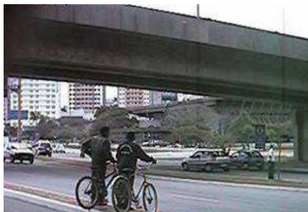
Foto obtida durante a pesquisa em 2003 demonstra que é antigo o problema da falta de estruturas de segurança para atravessar a avenida na saída da passarela
