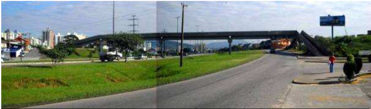
Vista geral da passarela da BR 282 no bairro Monte Cristo
