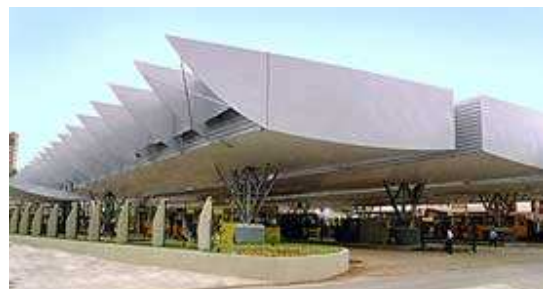
Fig.00 – Terminal de Integração - Centro de Joinville
